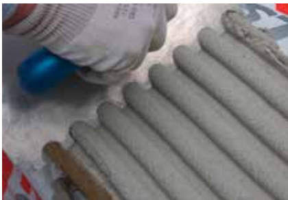
Bild 1: Verklebung eines Brandriegels – Vollflächige Verklebung, hier erreicht durch „Aufzählen“ auf den Untergrund und auf die Brandriegelrückseite (Floating-Buttering) sowie durch die dem Untergrund angepasste Zahnung.
