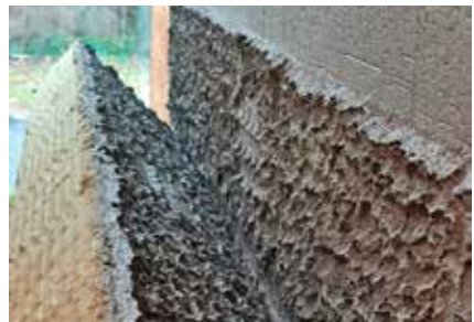
Bild 2: Verklebungskontrolle – Der Klebeflächenanteil muss kontrolliert werden. Hier wurde eine ausreichende und annähernd vollflächige Verklebung erreicht.
